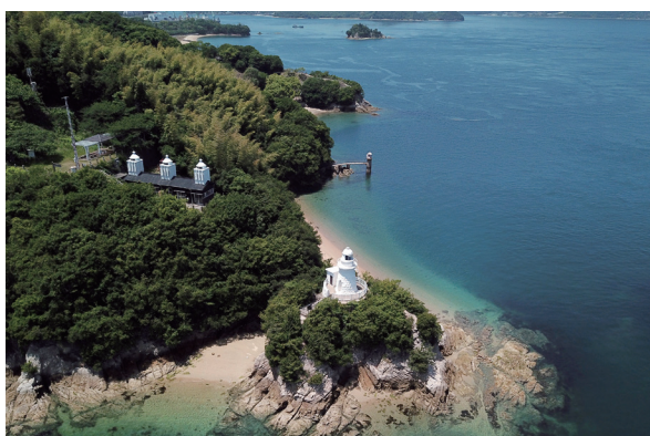
図9：重要文化財 旧大浜埼通航潮流信号所施設 (撮影 村上宏治)
