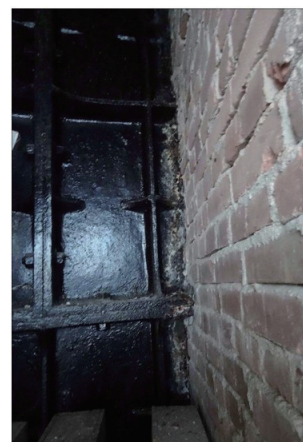
図9：目斗嶼灯台外側鉄鉄、内側レンガ「複合構造」 20)
