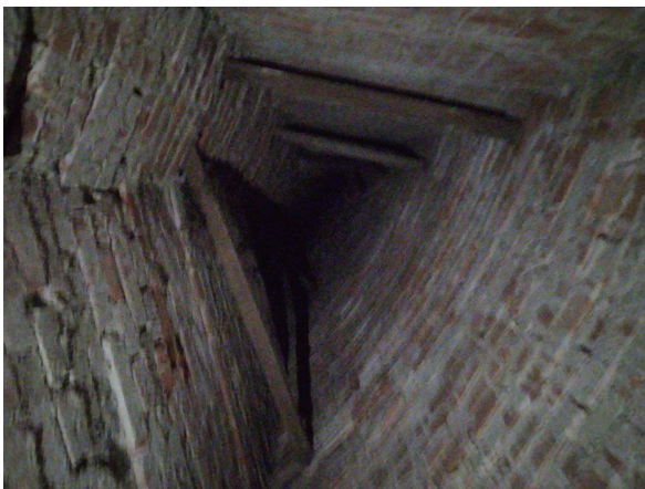
図8：白沙岬灯台の二重円筒構造 19)
