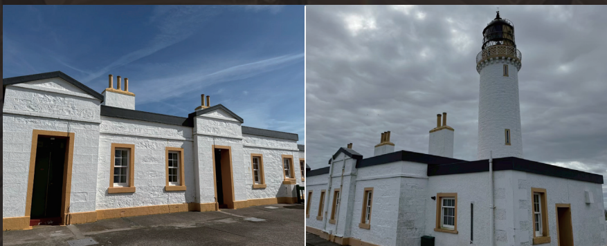
写真45、46: 3棟ある宿泊施設
