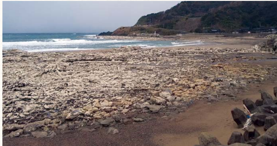
上/図1 地震前の皆月海岸の様子 下/図2 地震後の皆月海岸の様子
